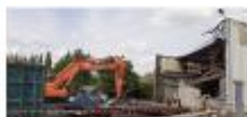
Démolition de bâtis vétustes - ZAE H. Durant
